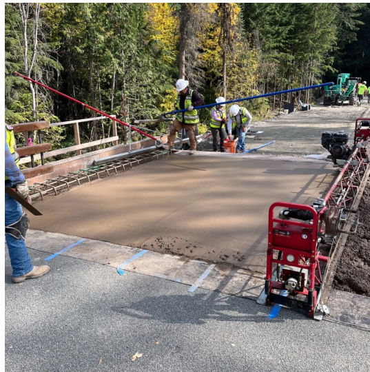
Approach slab pour
