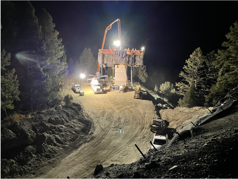
Pier 1 Cap Pour
