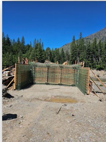
Endwall Rebar
