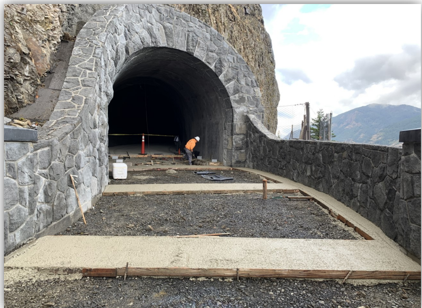
Basalt Band and Trench Drain Concrete Pour
