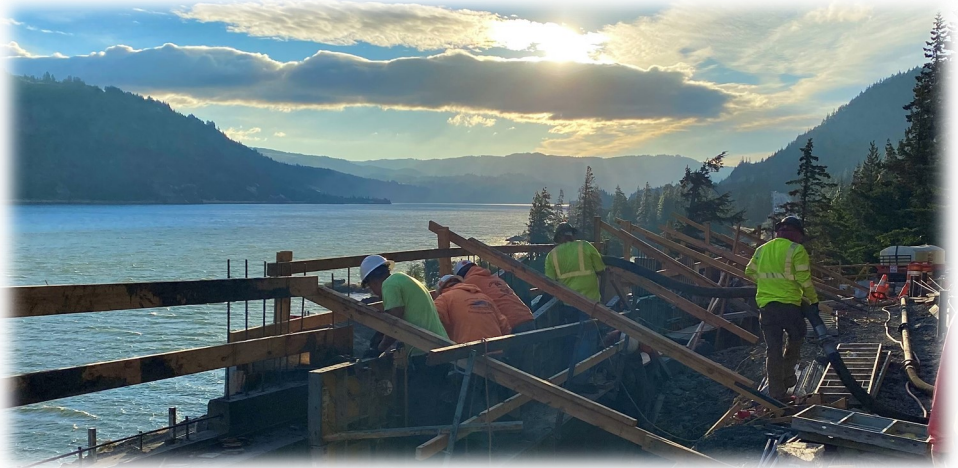
Concrete wall pour
