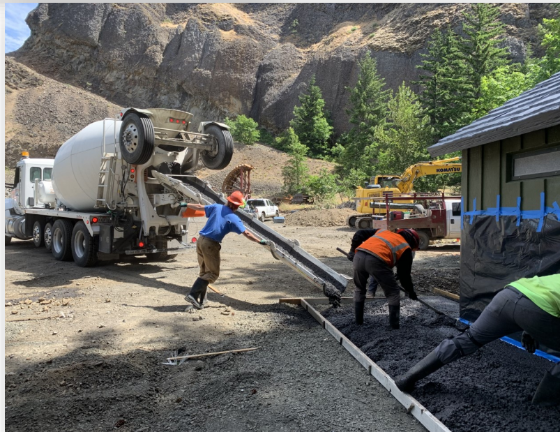
Vault Toilet Sidewalk Concrete Pouring
