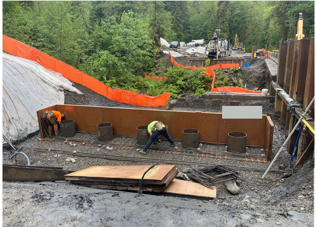
ICI installing pile cap rebar
