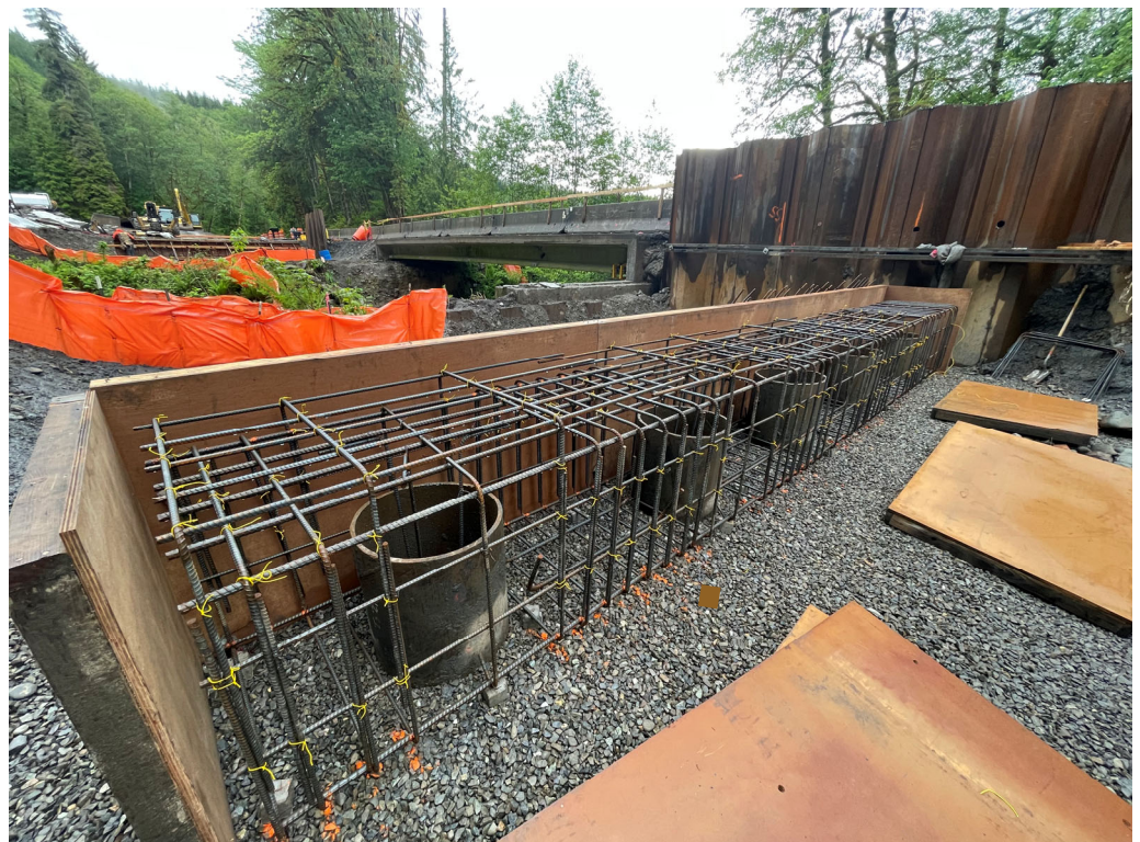
ICI installing pile cap rebar
