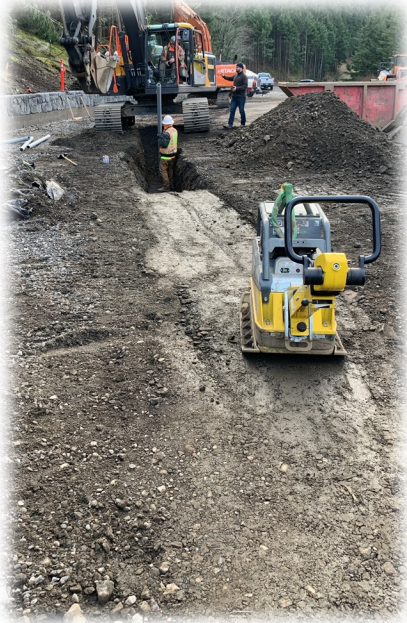
Installing electrical conduit
